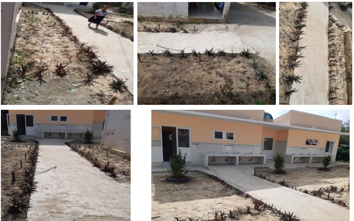
Lối vào của nhà vệ sinh học sinh.
